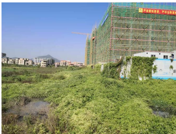
图 3 SQ040411 地块西侧边坡现状
