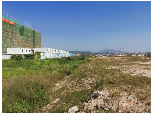
图 4 SQ040501 地块北侧边坡现状
