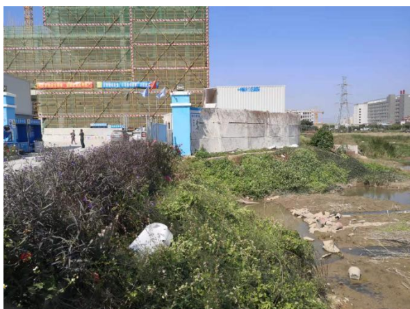
图 1 SQ040411 地块东侧边坡现状
