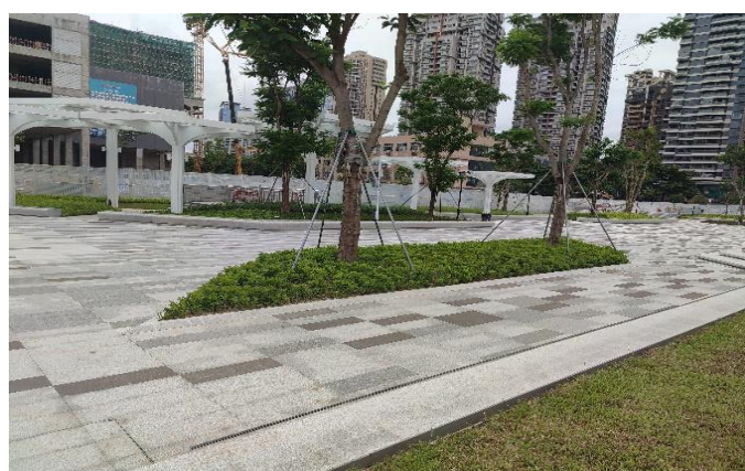
主体工程区西侧
