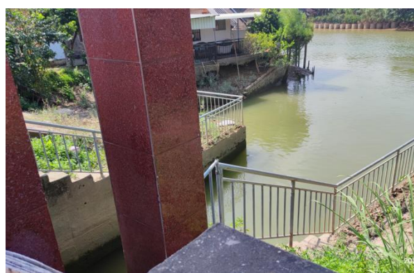
水闸外河侧出水口现状
