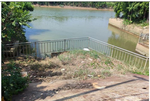
水闸外河侧平洲沥现状
